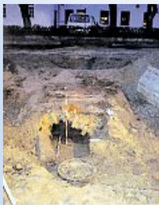
In der Nähe der Gaststätte Zum Alten Krug hat der Archäologe Thomas Budde einen alten Gang aus Backsteinen entdeckt. Auf einer alten Karte ist dessen Verlauf verzeichnet. Budde geht deshalb davon aus, dass es sich um eine frühe Kanalisation handelt.
