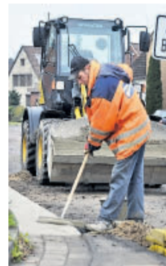
Bauarbeiten: Hier am Festanger in Dungenbeck.
