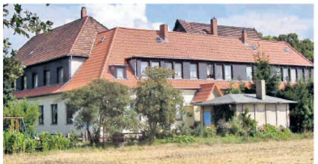
Das Gebäude heute: In der ehemaligen Simonstiftung befinden sich jetzt mehrere Mietwohnungen und das Deutsche Rote Kreuz. oh
